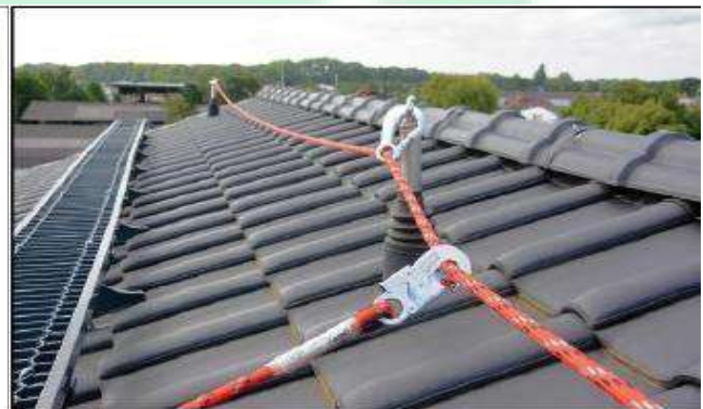
Gbr: Instalasi perangkat penahan jatuh tidak permanen perorangan horizontal (temporary horizontal life mbar dline)
