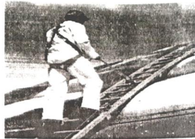
Gbr:Instalasi perangkat penahan jatuh permanen perorangan diagonal
